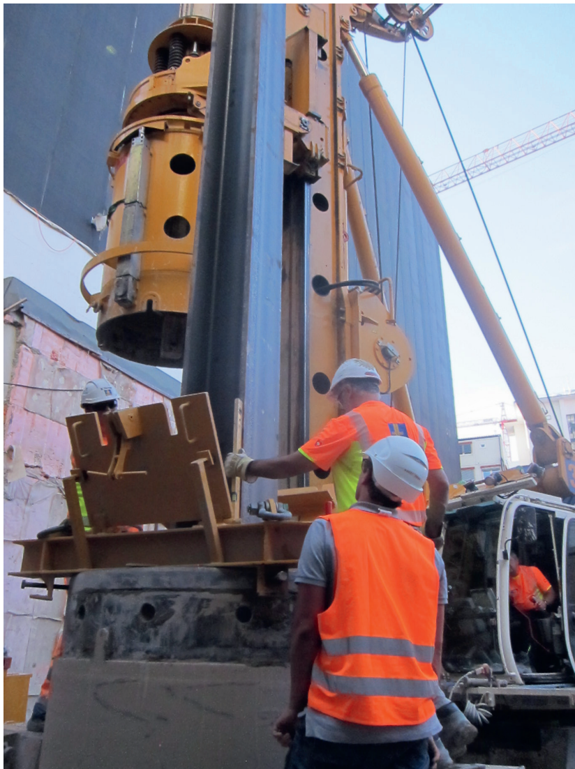
Einbau Primärstütze mit Justierrahmen
