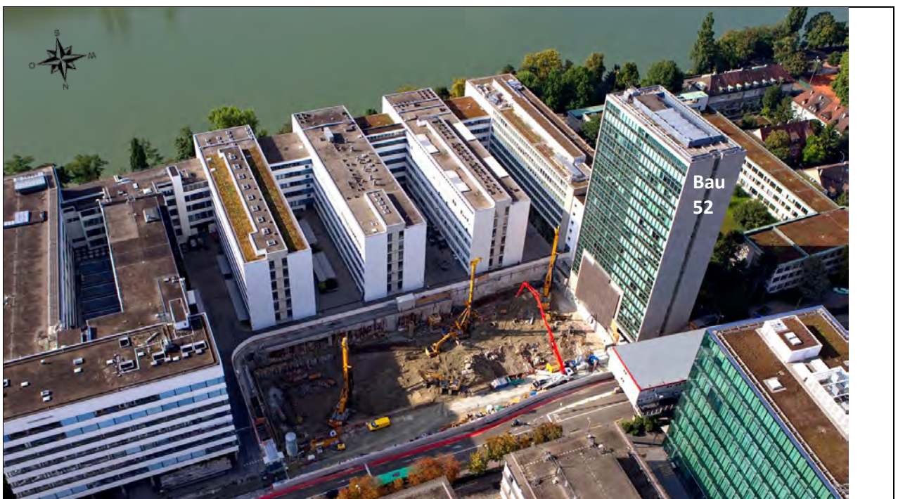
Abbildung 4: Luftbild des Projektareals während des Baus (Blickrichtung: Süden, Quelle: Roche)
